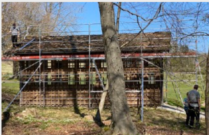
Sanierung der Dächer an Abschlaghütten
